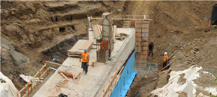
▼ Construction du tunnel reliant les deux édifices
